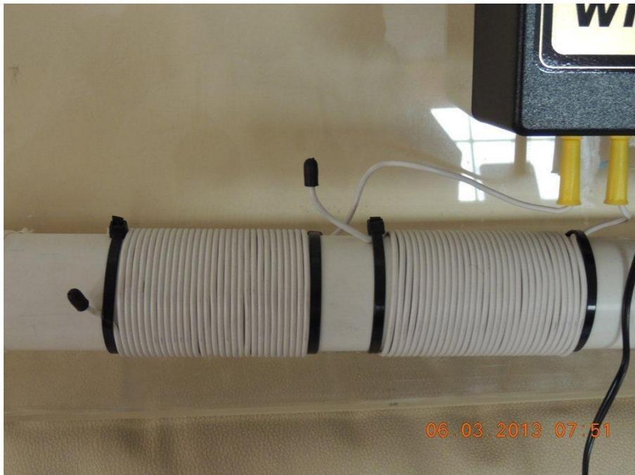
B.- LA MEJOR FORMA DE INSTALAR EL WATER KING, ES LO MAS CERCANO POSIBLE A LA TUBERIA DEL SISTEMA O DISPOSITIVO A PROTEGER Y DESINCRUSTAR. A UNA DISTANCIA DE MAXIMA DE 40 CENTIMETROS, Y A 15 CENTIMETROS DE LA TUBERIA COMO MINIMO, QUE ES EL ESPACIO REQUERIDO PARA INSTALAR LAS 4 ANTENAS, CON CONECTOR AMARILLO EN LA PARTE INFERIOR DEL EQUIPO.
