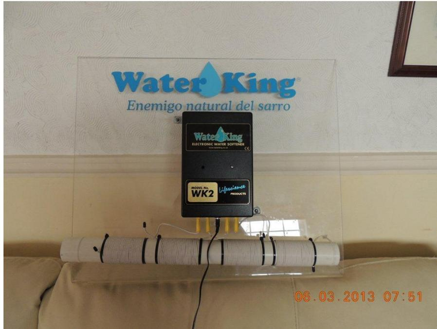
D.- CONECTAR LOS CUATRO GRUPO DE CABLES O ANTENAS A LA TUBERIA, INICIANDO DE IZQUIERDA A DERECHA, SUJETANDO UN EXTREMO ENCINTANDO A LA TUBERIA CON CINTO PLASTICO, SUMINISTRADO EN LA CAJA. COMO SE ILUSTR A CONTINUACION. LA PRIMERA ANTENA SE ENROLLARA DE DERECHA A IZQUIERDA Y LA SEGUNDA AL REVES DE IZQUIERDA A DERECHA. AL FINAL SE SUJETA CADA ANTENA ENROLLADA EN LA TUBERIA CON OTRO CINTO
