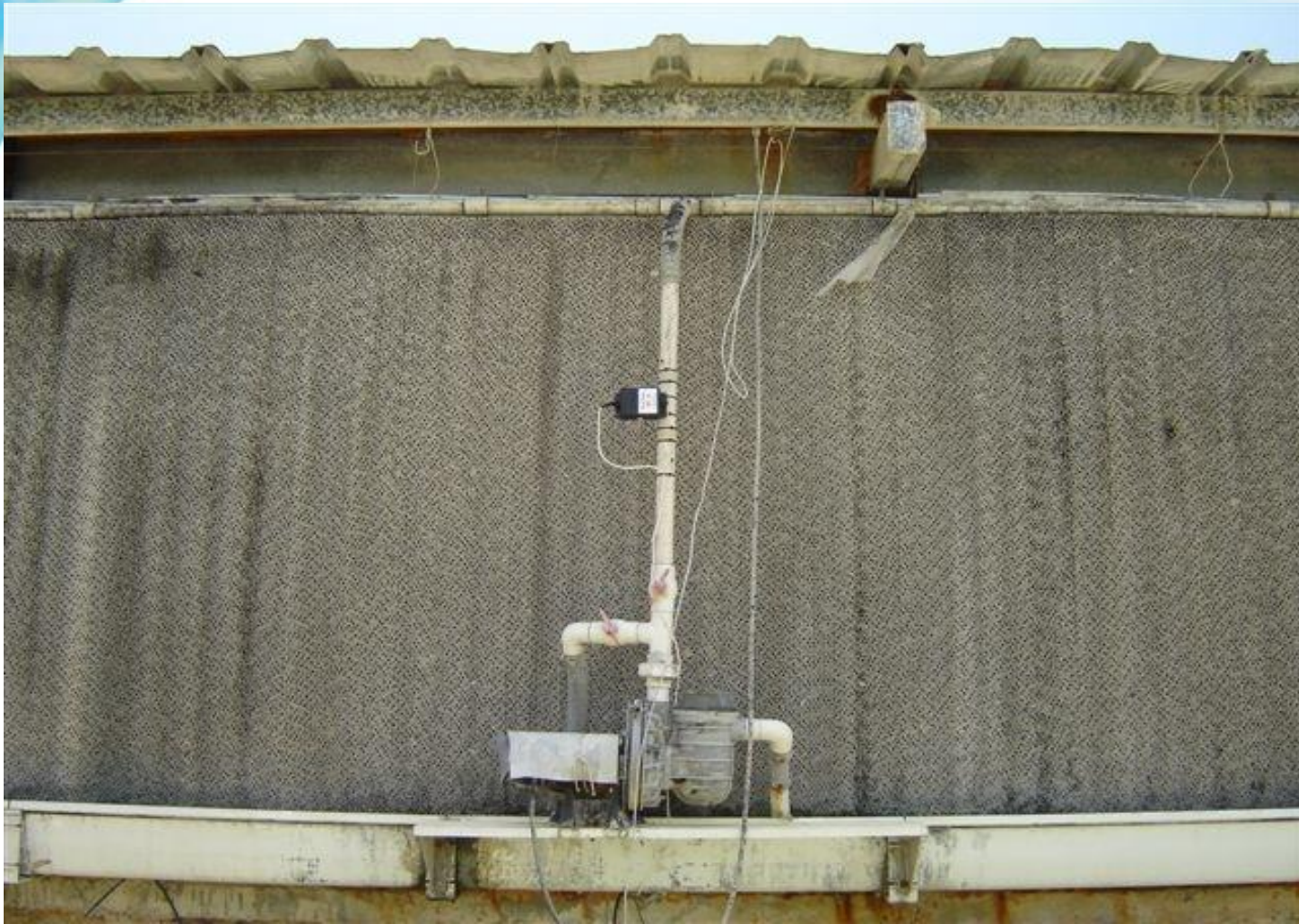
Equipo Water King instalado
