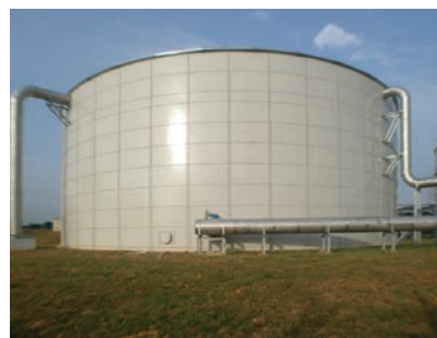
Almacenamiento de agua potable
