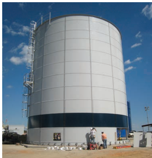
Instalación para generación. Agua de proceso
