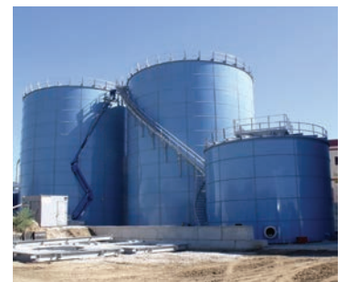
Tanques digestores anaeróbicos
