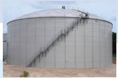
Construcción RTP. Almacenamiento de agua potable. 17.000 m 3 (4.5 millones de galones)
