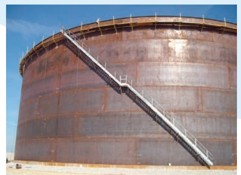
Tanque para líquido soldado en campo
