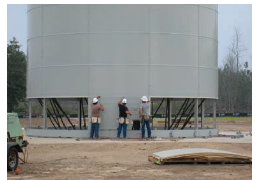
Tanque vertical elevado desde el nivel del suelo
