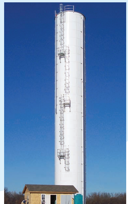
Tanque elevado (torre) pernado
