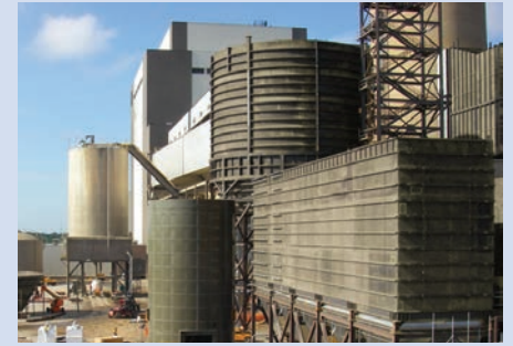
Tanque RTP pernado, soldado en campo y construcción híbrida
