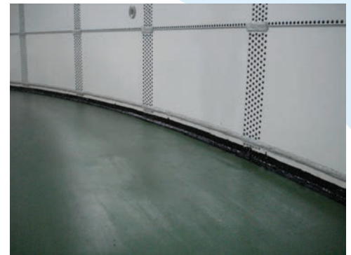
Interior de un tanque de gran tamaño para almacenamiento de agua municipal. Anillo base de asiento con fondo de concreto
