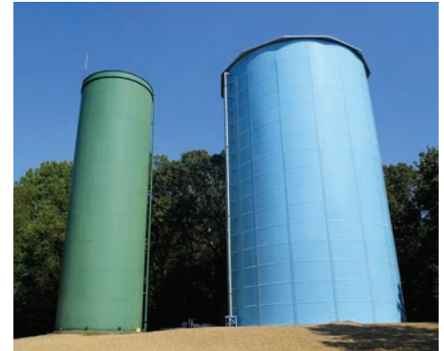
Tanque vertical soldado en sitio
