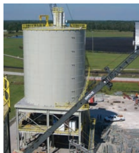
RTP pernado para almacenamiento de proceso
