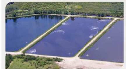
Lagunas de Aguas Residuales
