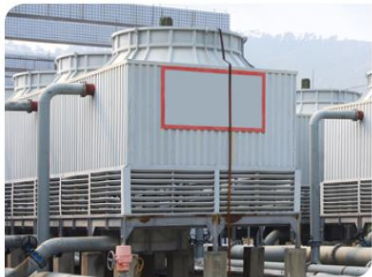
Torres de Enfriamiento
