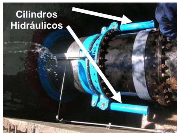
Un extremo del cilindro hidráulico está fijo al cuerpo de la válvula, mientras el otro extremo está fijo al obturador cilíndrico deslizante.
