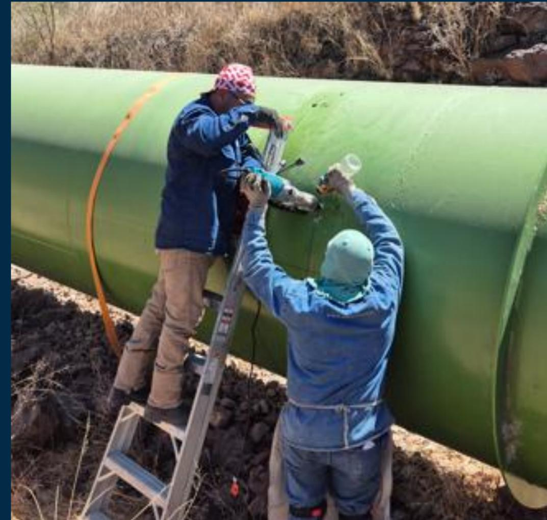
Perforación de la tubería utilizando taladro magnético, realizada en los puntos previamente marcados como referencia para la instalación de los sensores.
