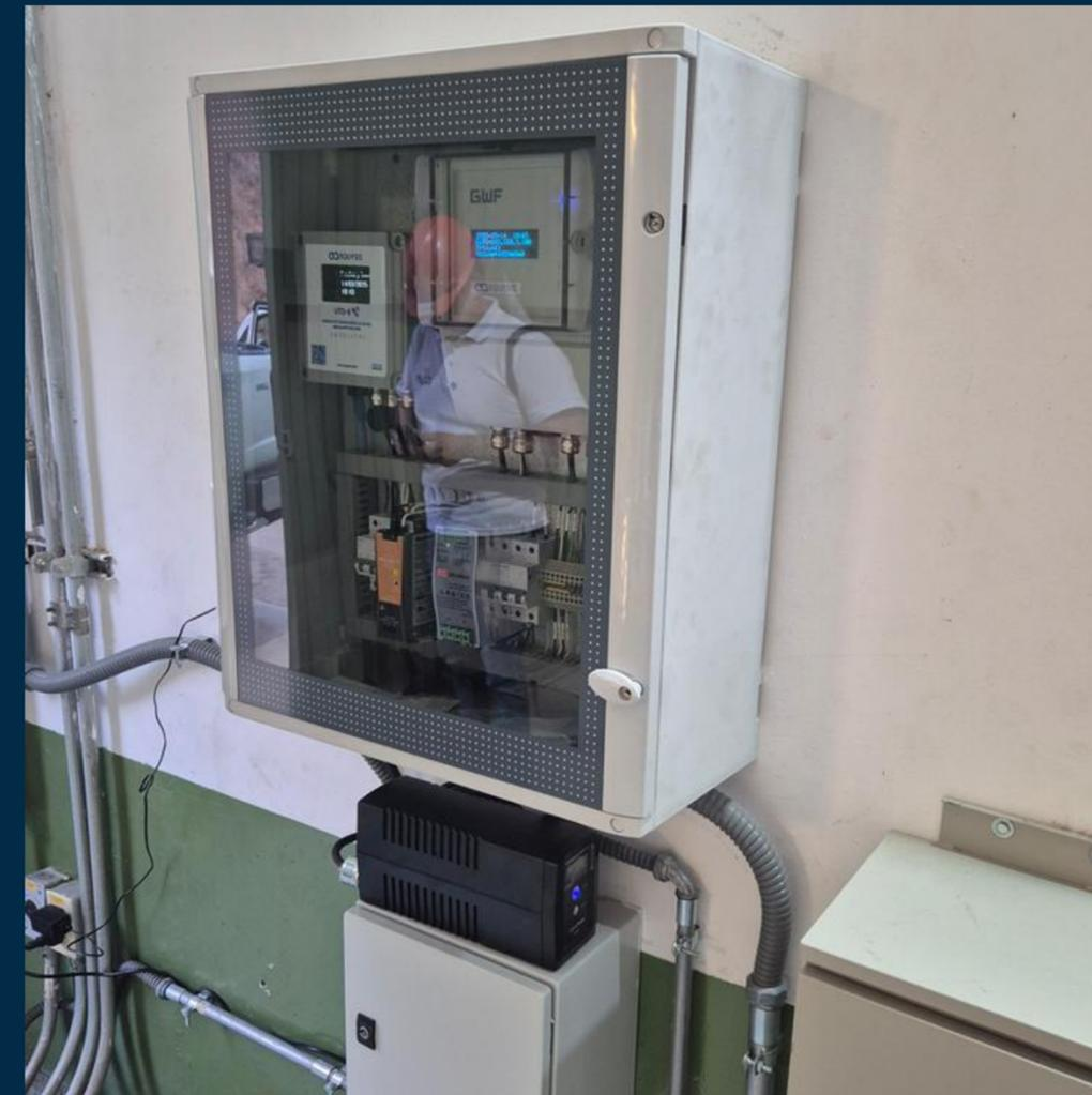
Sistema de telemetría y medidor instalados dentro del gabinete, cumpliendo con los requisitos establecidos por la norma NMX-AA-179-SCFI-2018.
