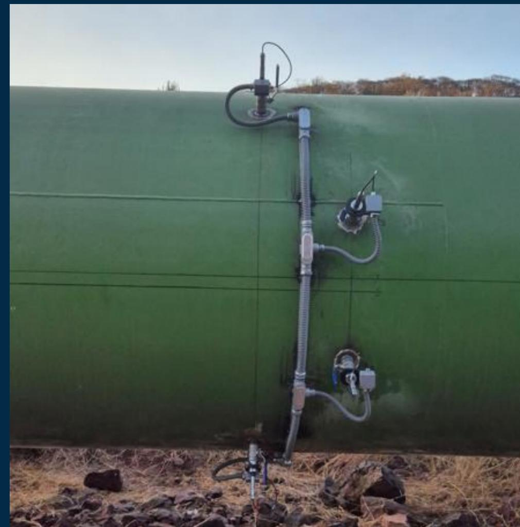
Montaje de sensores ultrasónicos y conexión eléctrica correspondiente, garantizando su correcta instalación y funcionamiento conforme a las especificaciones del sistema de medición.
