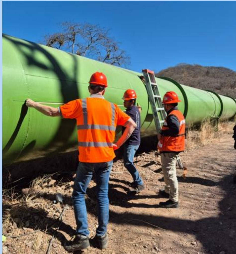
Toma de medición en tubería de 1.8 metros de diámetro, incluyendo el marcado de la ubicación de los sensores.
