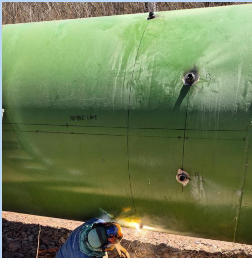
Soldadura de coples de conexión para el montaje de los sensores ultrasónicos, asegurando su correcta alineación y fijación en los puntos de medición establecidos.
