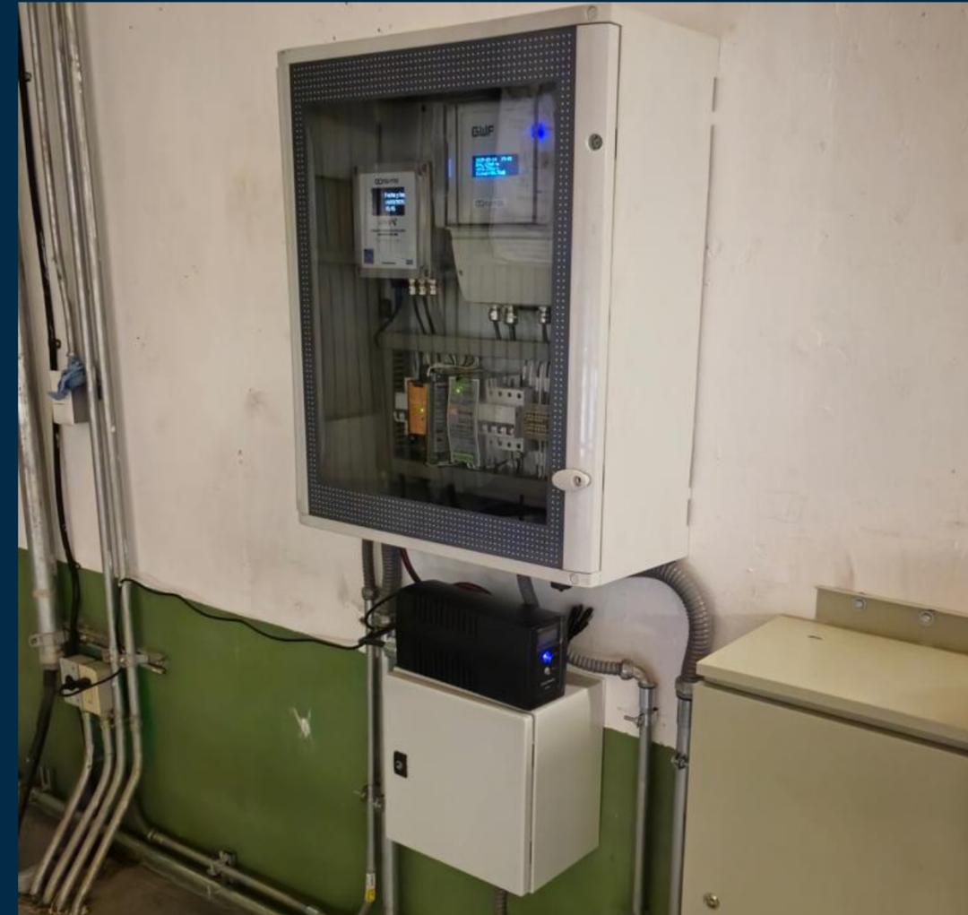
Sistema de telemetría y medidor instalados dentro del gabinete, cumpliendo con los requisitos establecidos por la norma NMX-AA-179-SCFI-2018.
