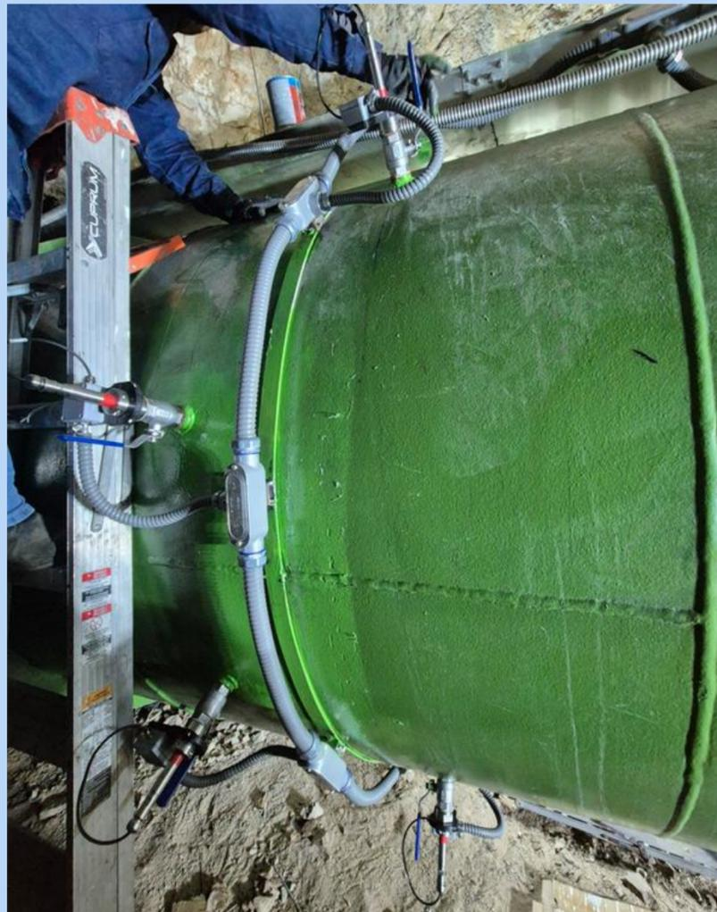
Sensores instalados y alineados correctamente, listos para la puesta en operación del sistema de medición.
