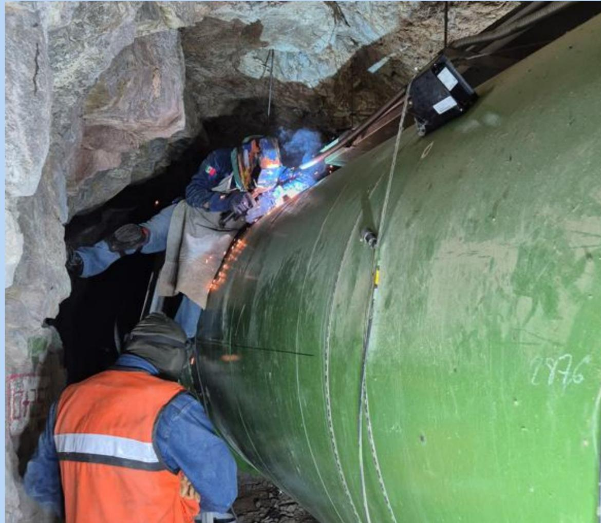
Soldadura de coples de conexión para el montaje de los sensores ultrasónicos, asegurando su correcta alineación y fijación en los puntos de medición establecidos.
