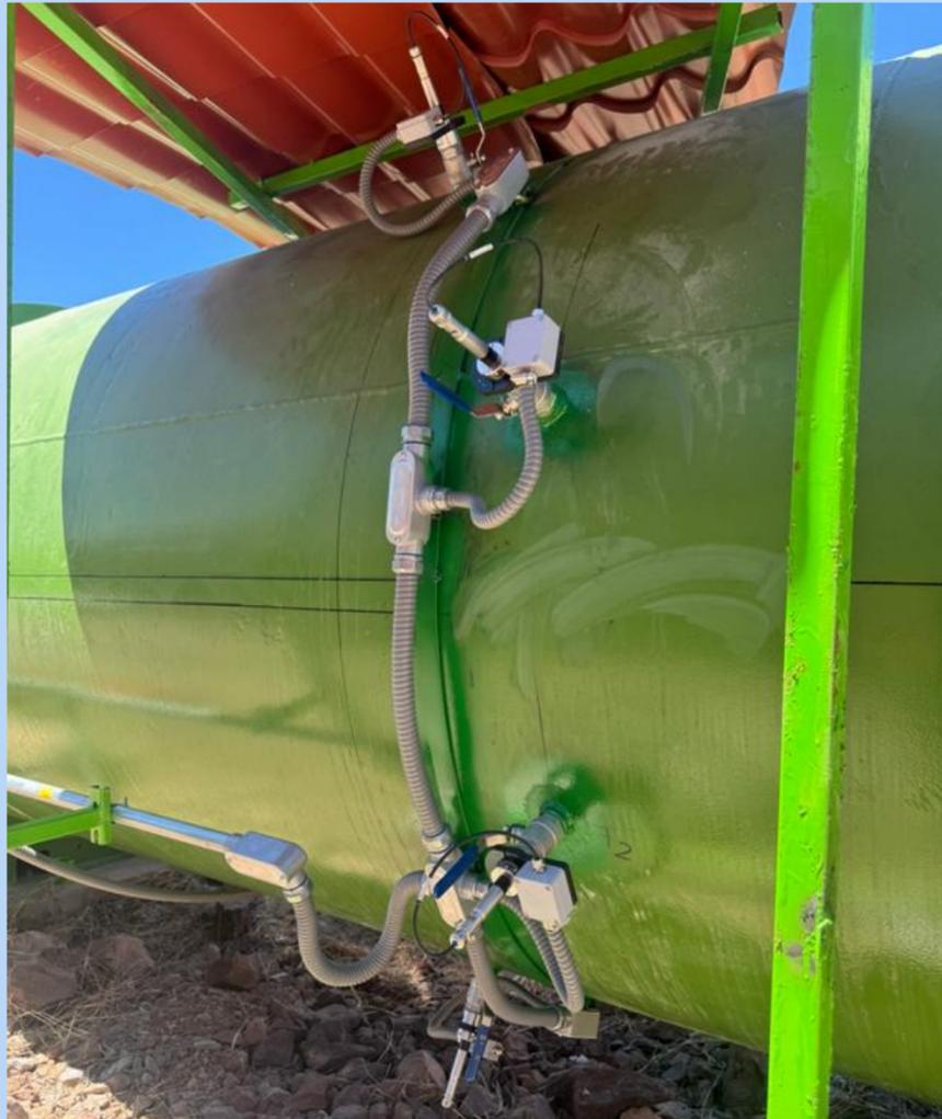
Sensores instalados y alineados correctamente, listos para la puesta en operación del sistema de medición.
