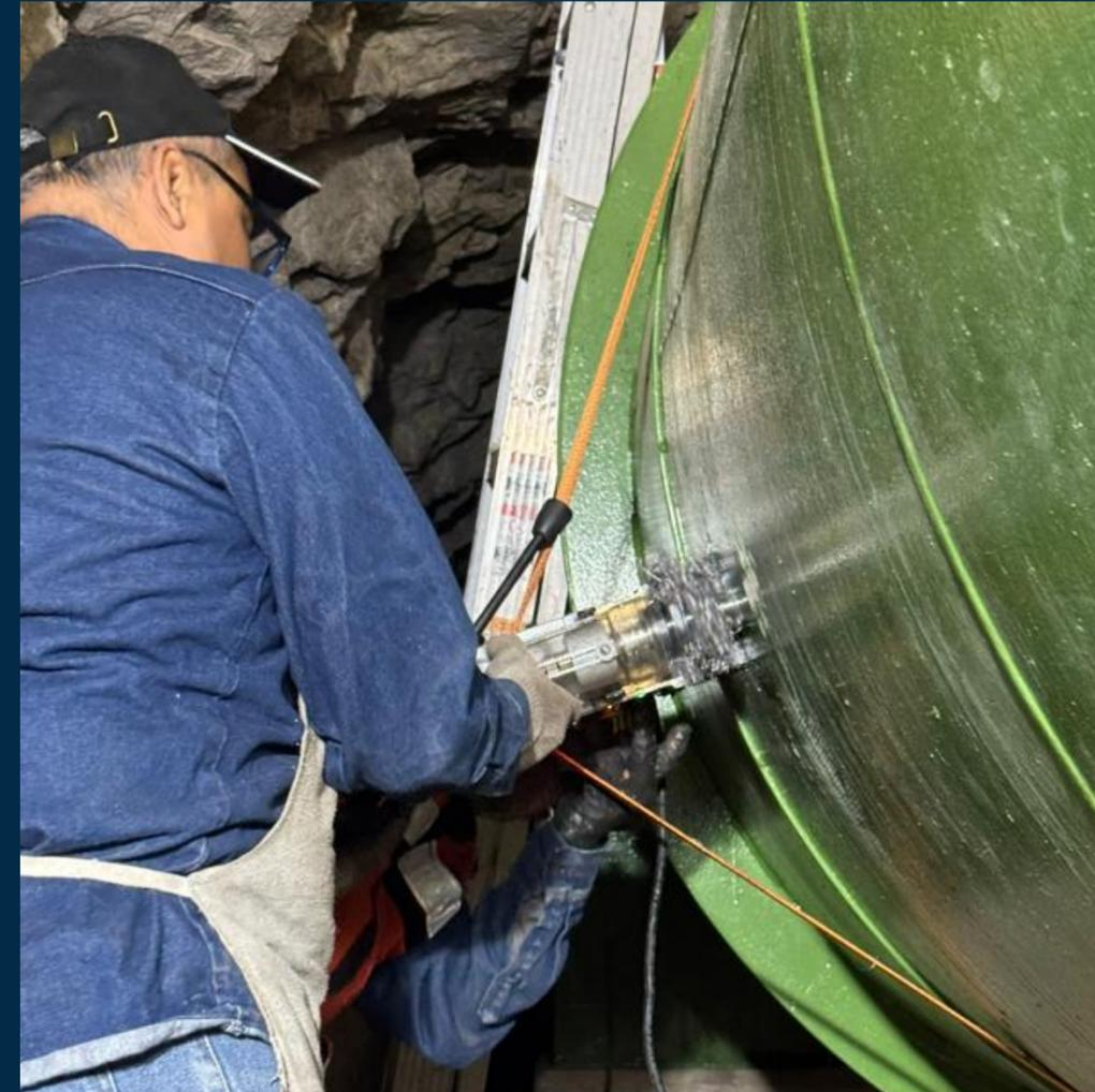
Perforación de la tubería utilizando taladro magnético, realizada en los puntos previamente marcados como referencia para la instalación de los sensores.
